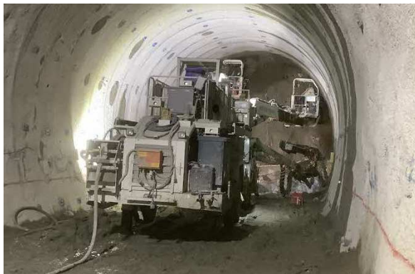
写真-1 装薬状況
