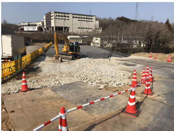
写真 盛土状況
