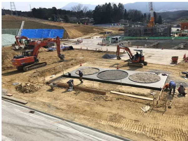
写真 基礎工状況
