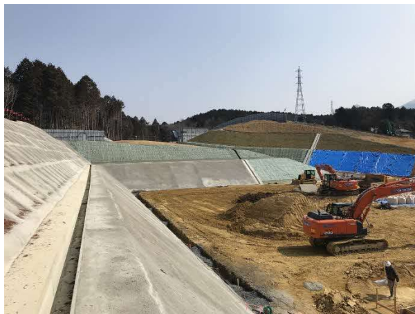
写真 法面吹付状況
