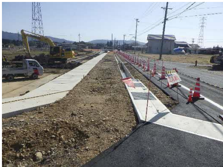
付替水路道路工事状況
