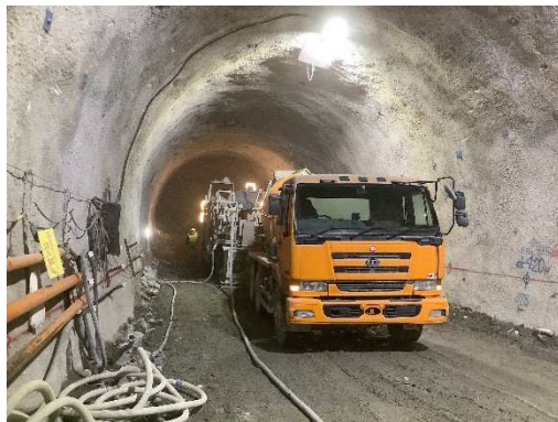
写真-1 吹付け状況
