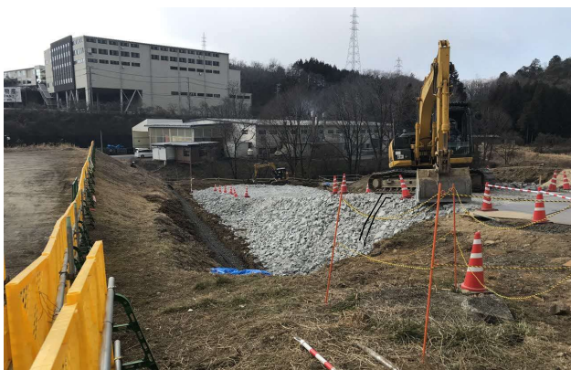
写真 盛土状況
