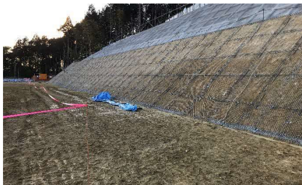
写真 法面整備状況
