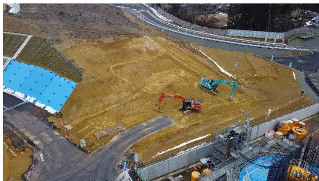
写真 切土施工状況
