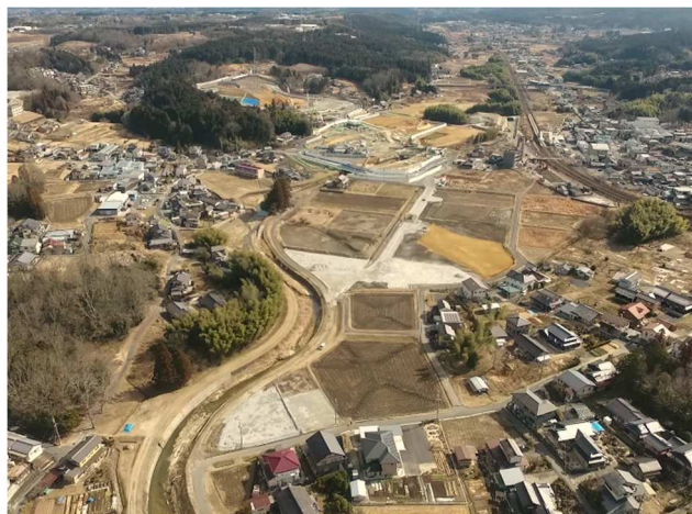
【状況写真 R5.2月時点】
