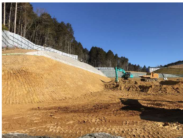
写真 切土施工状況
