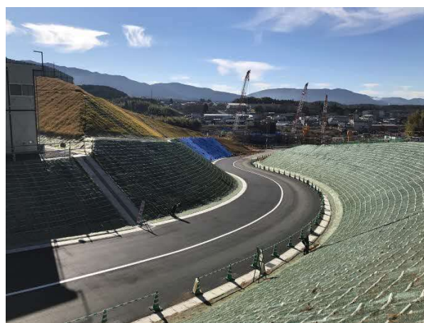
写真 工事用道路状況
