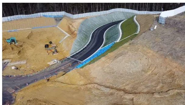
写真 工事用道路状況
