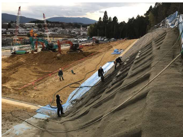
写真 法面吹付状況
