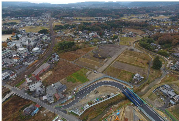
【状況写真 R4.11月時点】
