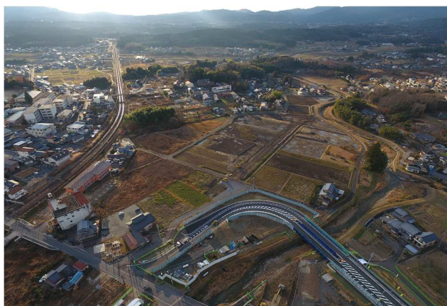
【状況写真 R4.12月時点】
