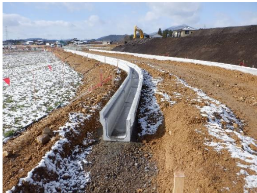
付替水路工事状況
