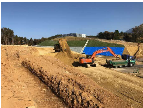
写真 掘削残土運搬状況
