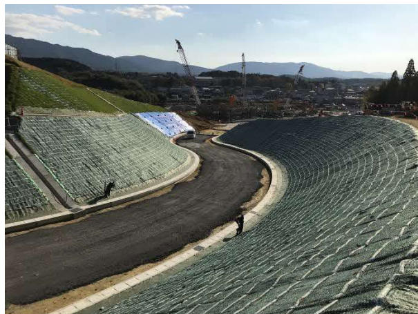
写真 工事用道路状況
