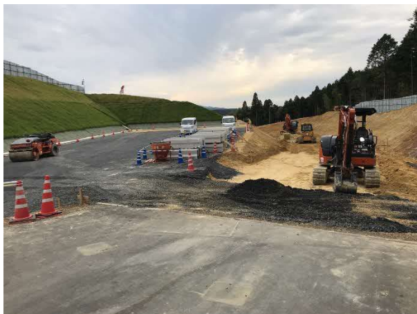
写真 ヤード造成状況
