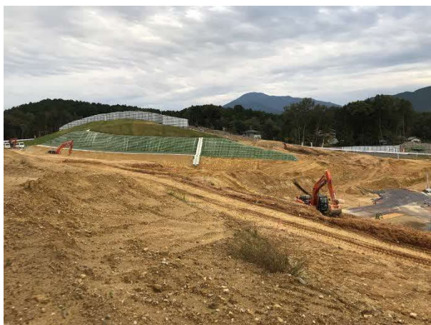
写真 法面緑化状況
