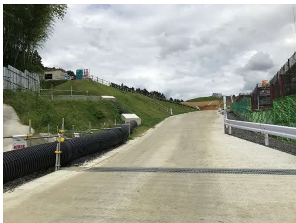
写真 法面緑化状況
