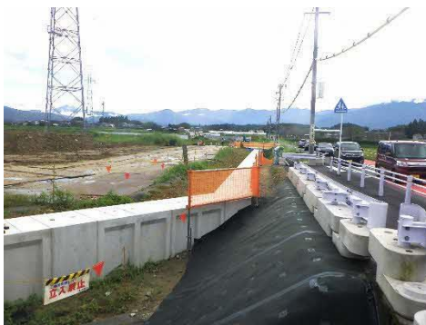
付替水路・工所用仮設道路状況
