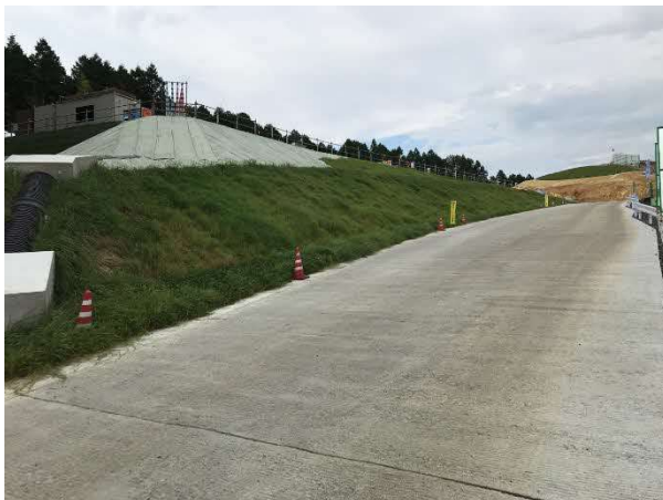
写真 法面緑化状況
