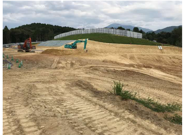
写真 ヤード内掘削状況
