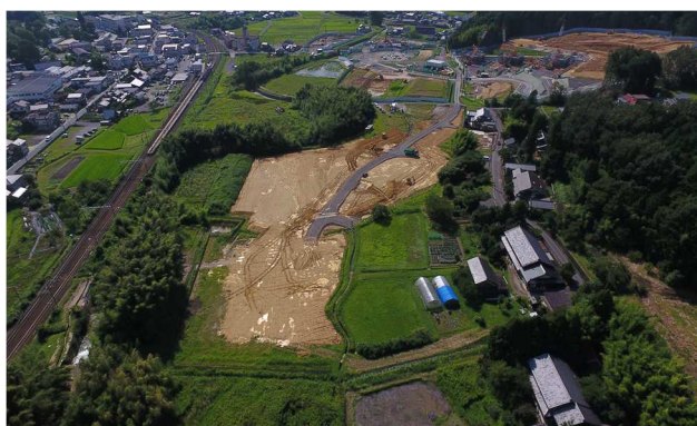
【状況写真 R4.7月時点】
