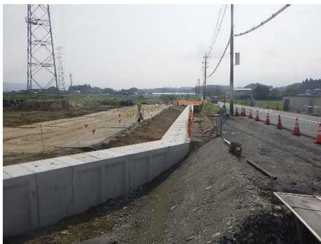
付替水路・工所用仮設道路状況
