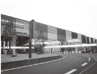
県営筑後広域公園区域内に設置される珍しい駅
