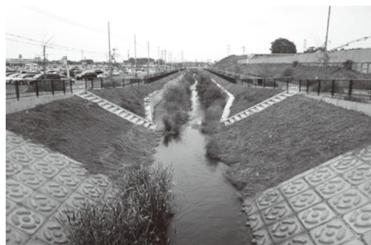
駅前広場と一体的に整備された男堀川
