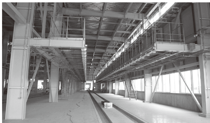
白山総合車両所車体検修・塗装場
