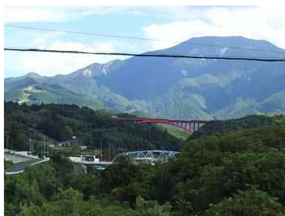
手前:国道19号 奥:中央自動車道
