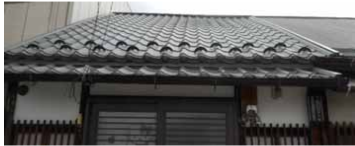
日本瓦風のガルバリウム鋼板
