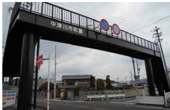
▲歩道橋の色彩配慮例 茶系の落ち着いた色彩により、圧迫感が軽減され、景観にも調和しています。
