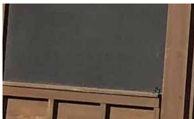
木材と吹付け
