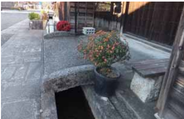
▲石張りによる水路（落合宿）
