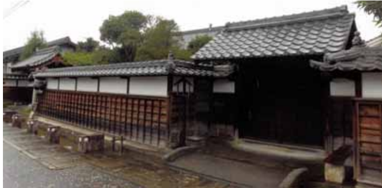
▲伝統的な建築物例（落合宿本陣）
