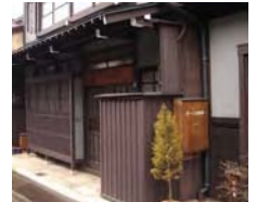
通りから望見できなくした室外機
