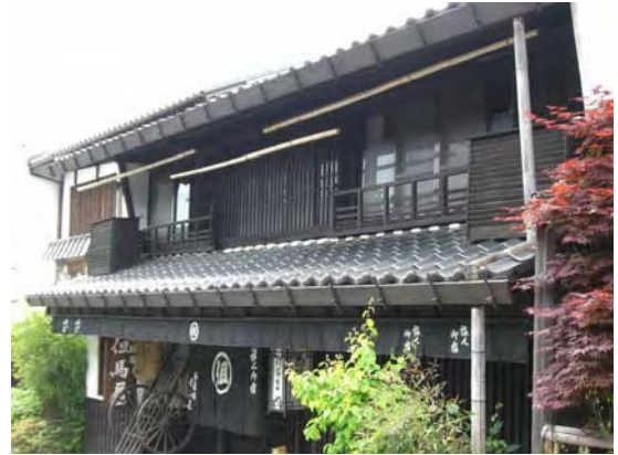
室外機に目隠しを施し、周囲の景観に調和している
