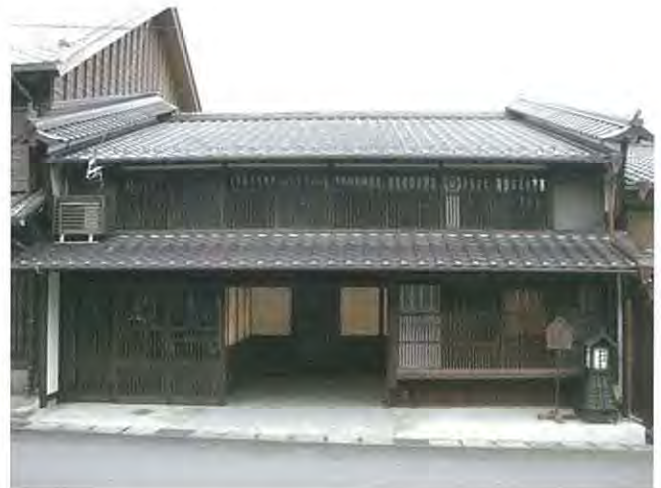
修景工事後東側写真
