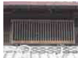
縦線を基調とした和風格子壁面と同色に塗った室外機
