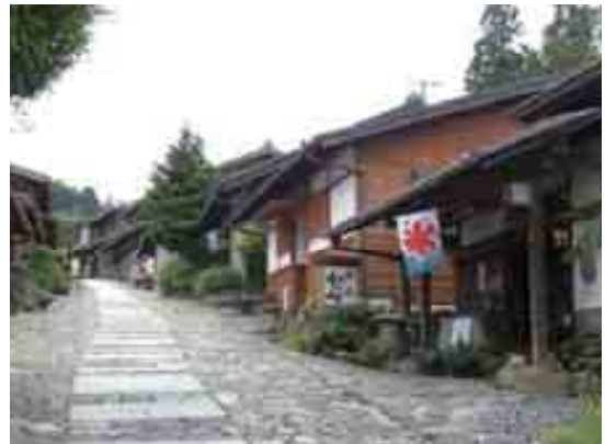
2階建ての民家が並び連続性が見られる
