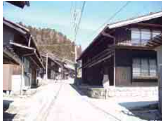
2階建ての民家が並び連続性が見られる 峠
