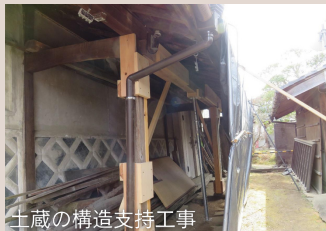
土蔵の構造支持工事
