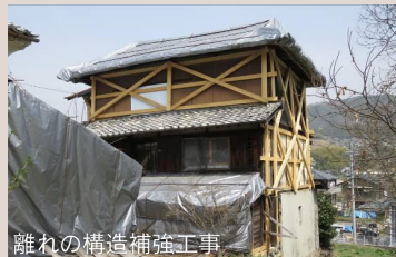
離れの構造補強工事
