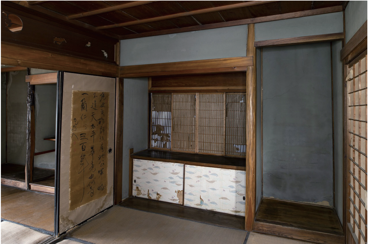
12 離れ 二階 次の間 座敷飾 西面南側に間口1間の床脇、北側に間口半間の床を備えている。床脇は地袋の上に縦繁障子4枚を引き違いに建て込んで、付書院を兼ねた意匠となっており、独創的な意匠の床脇である。
