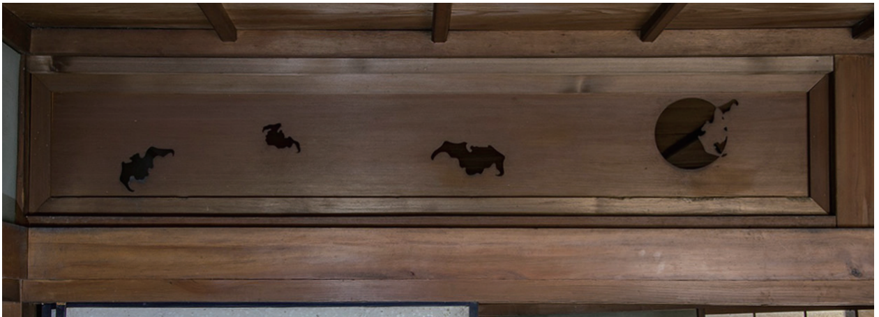
15 離れ 二階 主座敷・次の間境欄間 西側南面 蝙蝠の透かし彫り板欄間 蝙蝠模様は煎茶趣味の意匠
