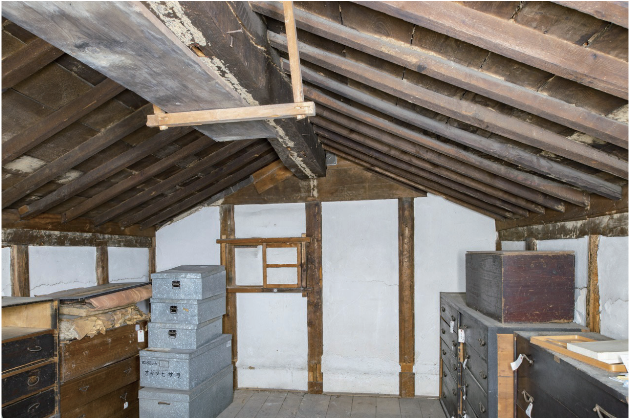
28 土蔵 二階内部 東室東面
