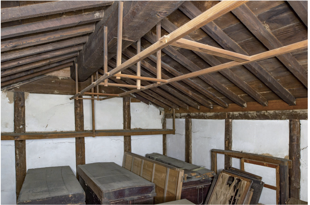
26 土蔵 二階内部 西室西北面
