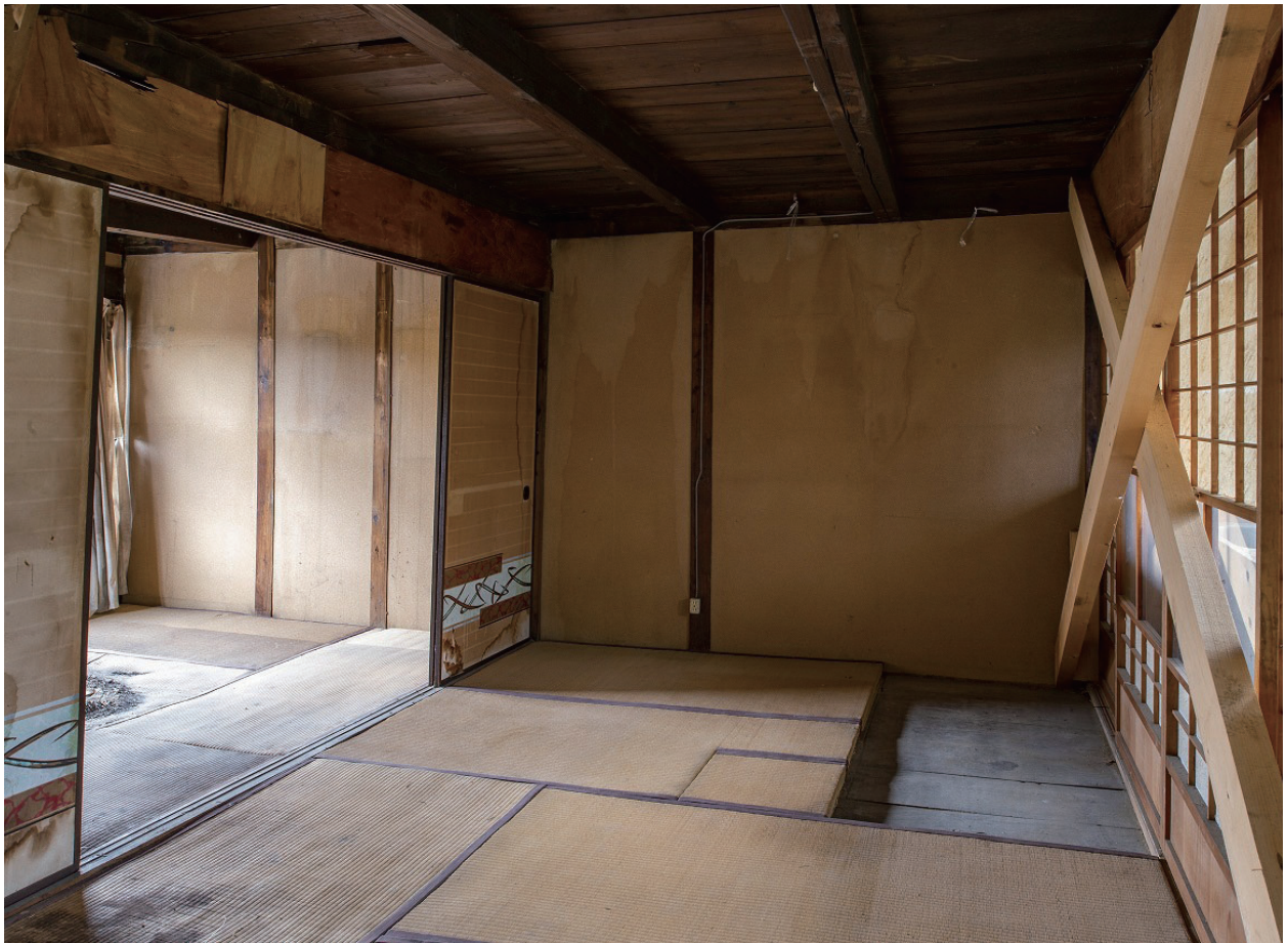
10 離れ 一階 南西隅の六畳間から東側の六畳間にかけて 筋違は最近の応急的な補強
