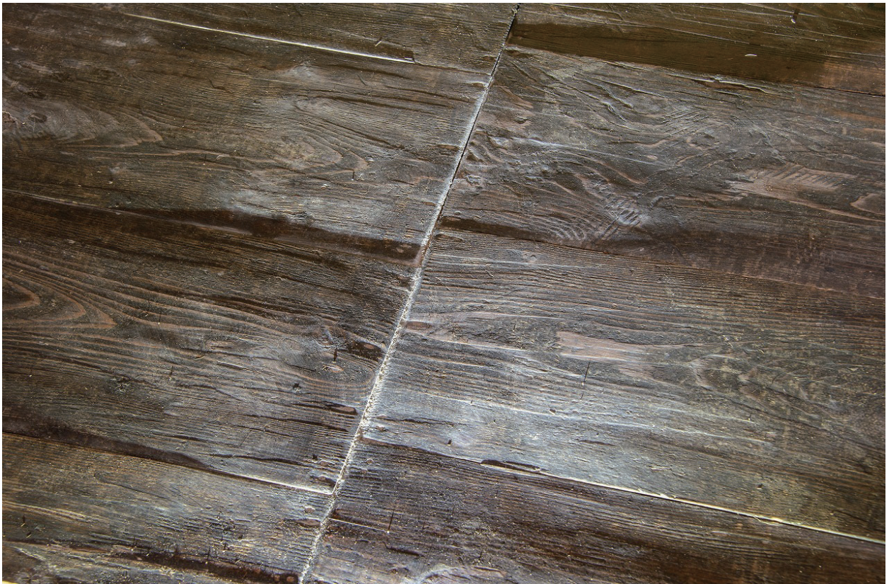
13 同上 床板 黒変し、摩耗痕があるので、当初は床板敷きであったことがわかる。
