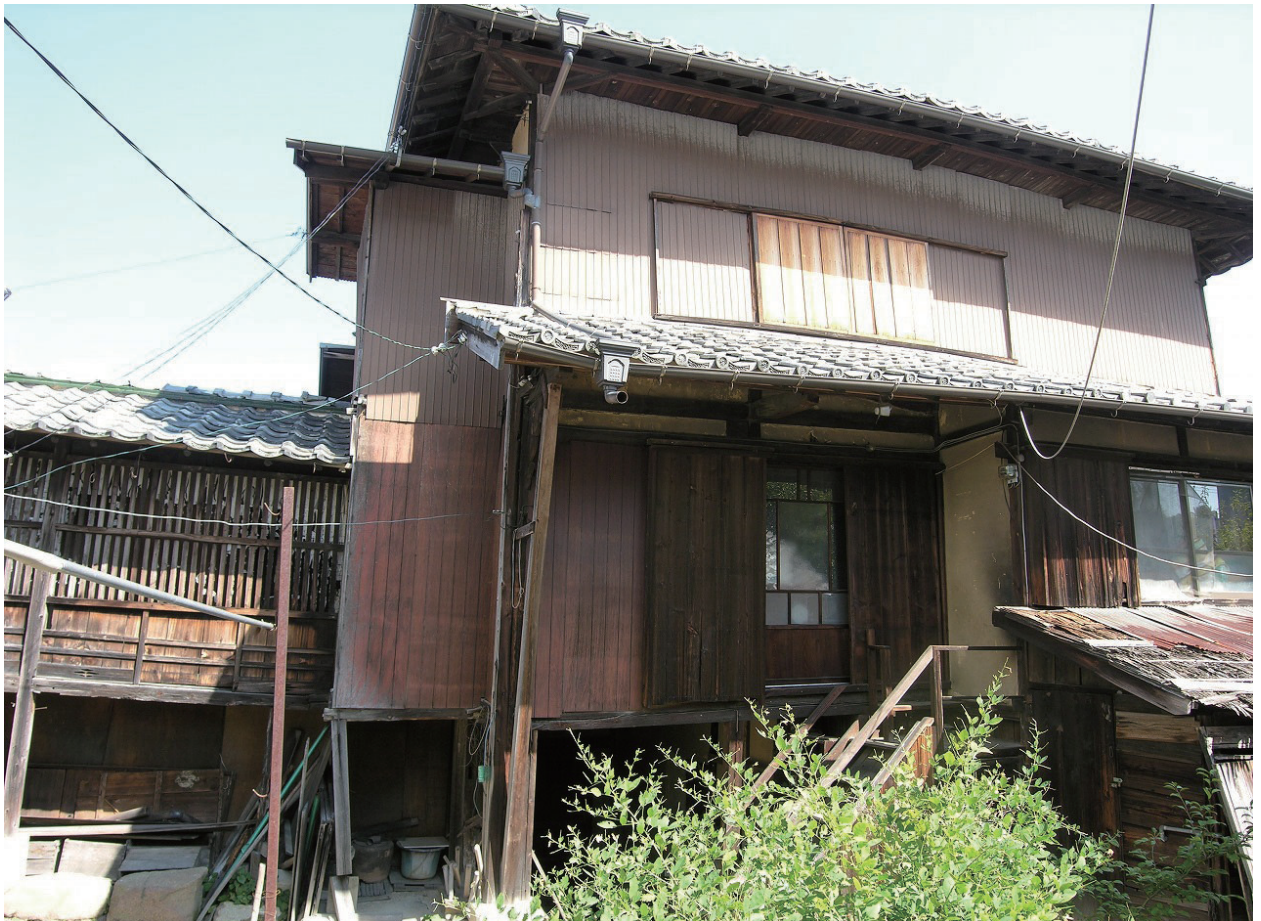
1 離れ 西面北側 平成 19 年当時
