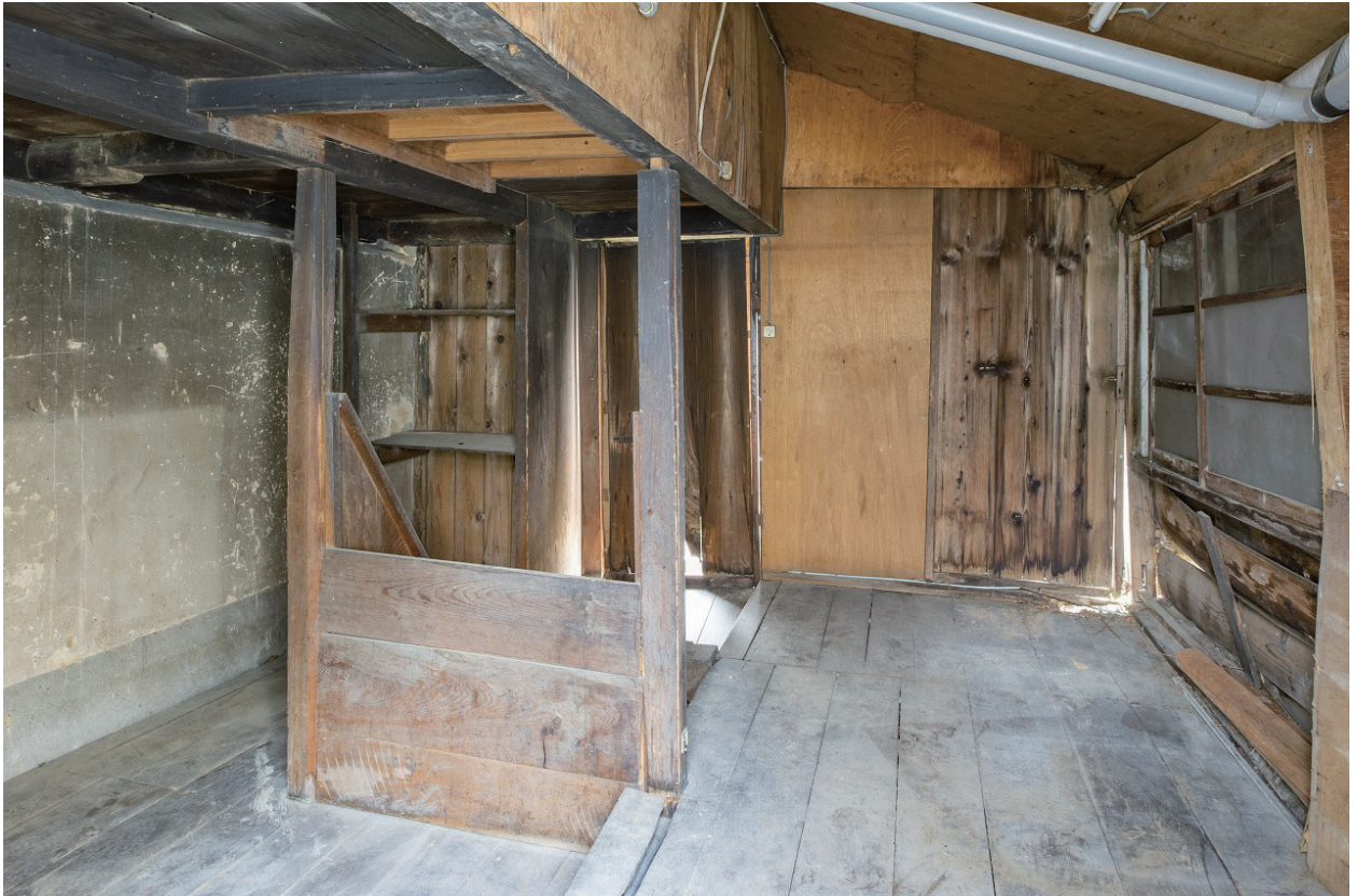
8 離れ 半地下 倉庫内部
