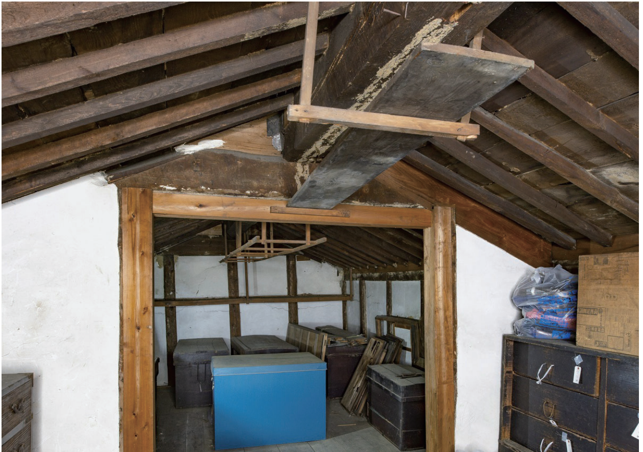
27 土蔵 二階内部 東室から西室を見る
