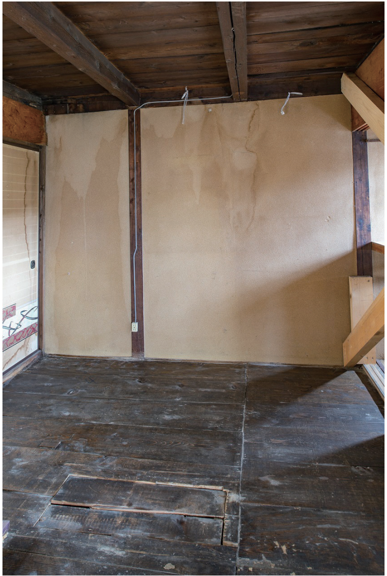
12 離れ 一階 南西隅の六畳間 畳を上げて床板を表す
