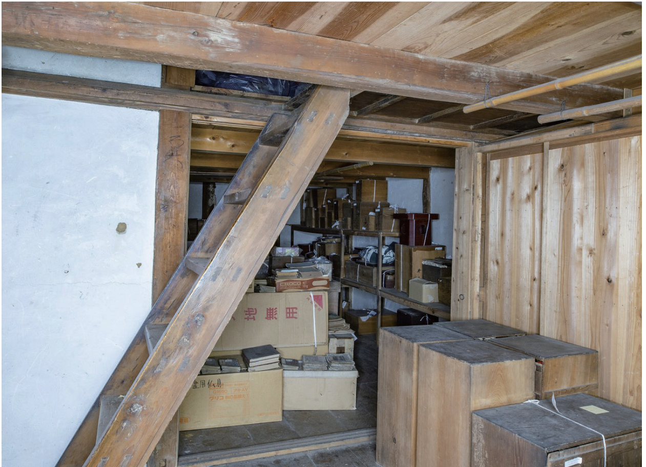
25 土蔵 一階 内部 西室から東室を見る
