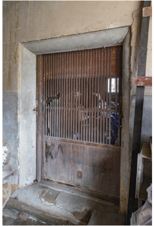
6 離れ 半地下土蔵 北面出入口
