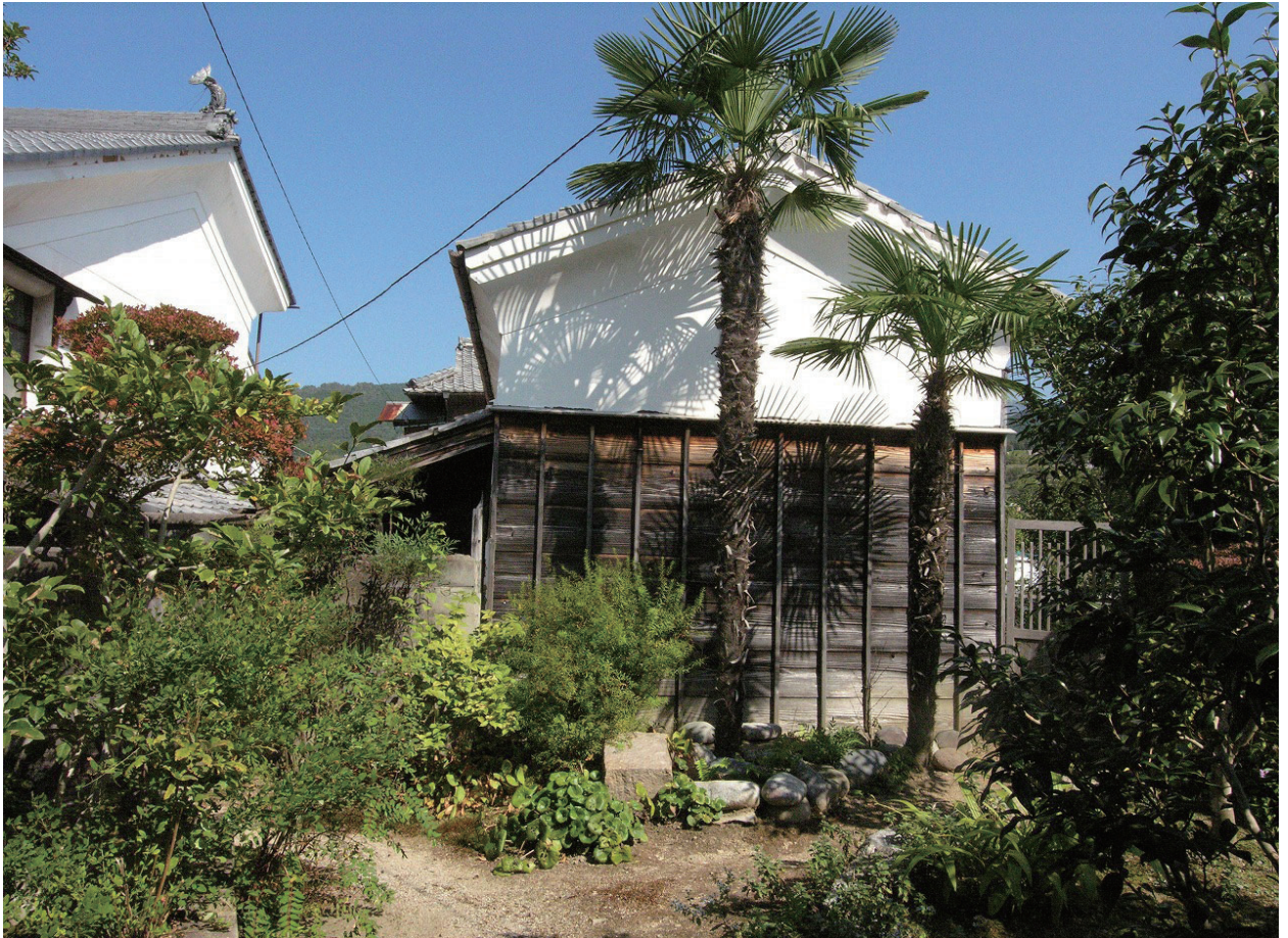
24 土蔵 西面 平成 19 年当時
