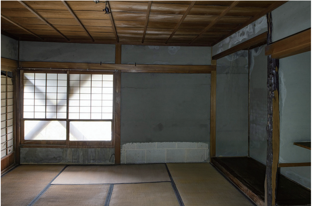
14 離れ 二階 主座敷 南面
