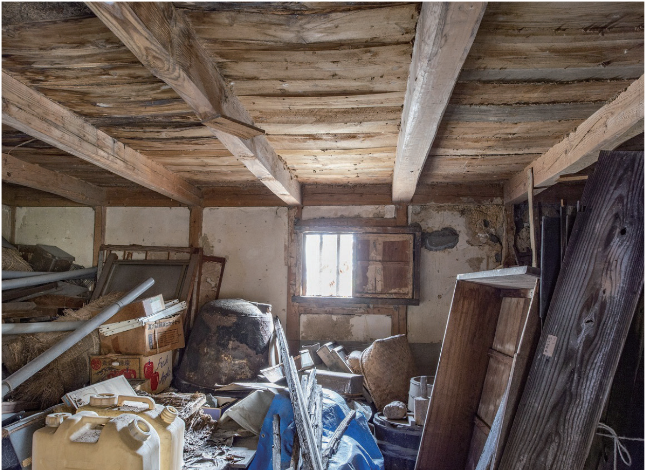
7 離れ 半地下 土蔵内部
