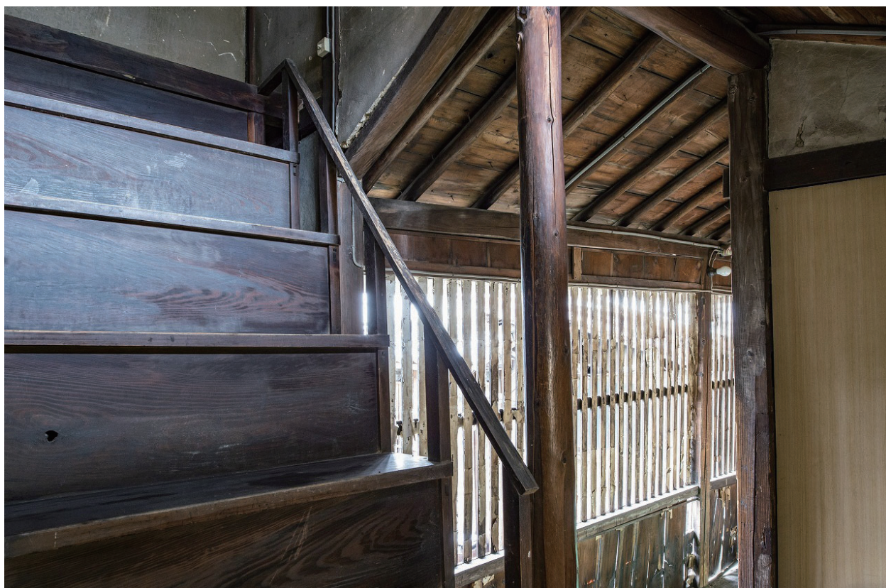
15 箱階段から渡り廊下を見る
