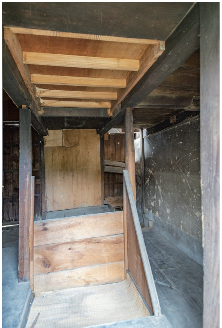
9 同上 天井の後補材部分に、当初は一階に上がる階段が設けられていた。
