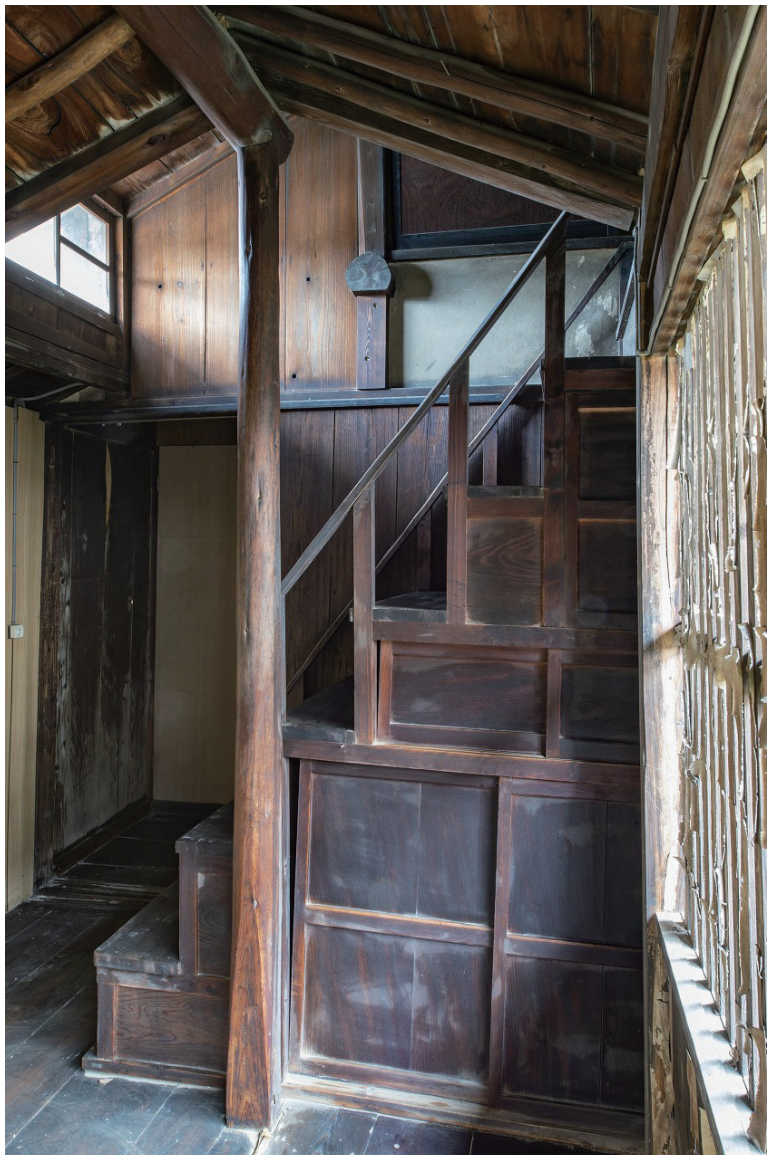
14 渡り廊下南端に設置された離れの二階に上がる箱階段
