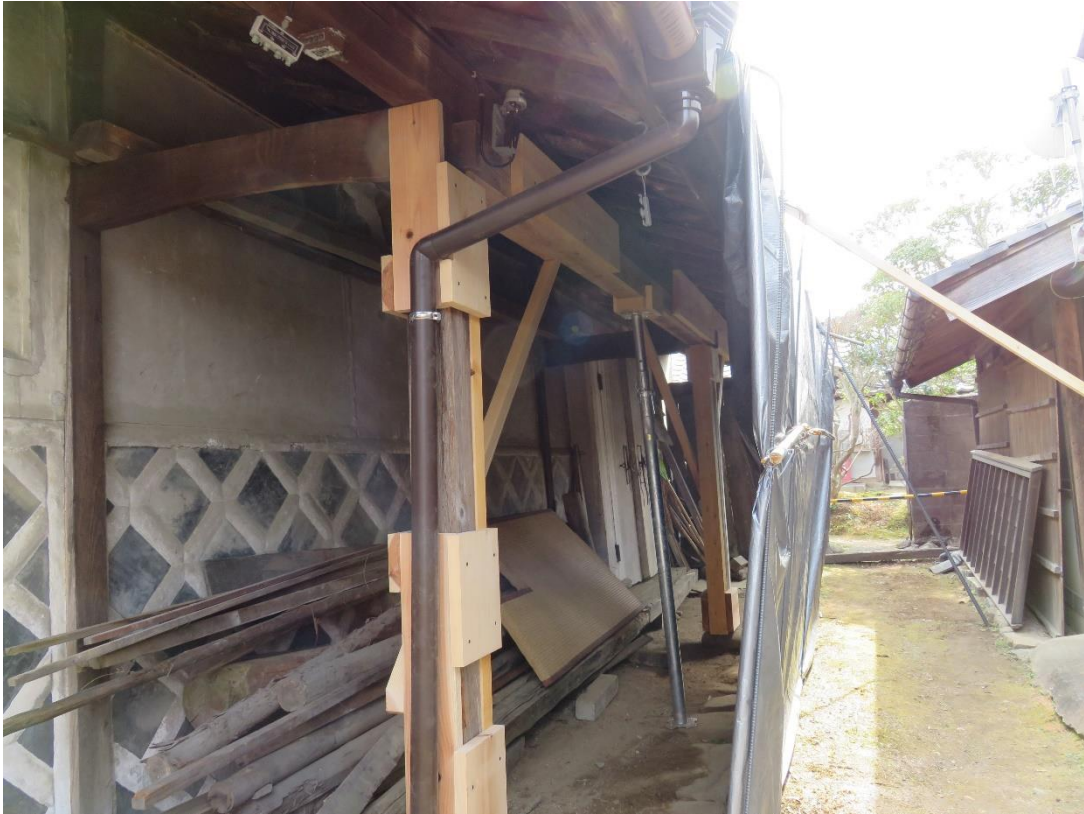
土蔵前庇梁補強工事（平成 28 年度）
