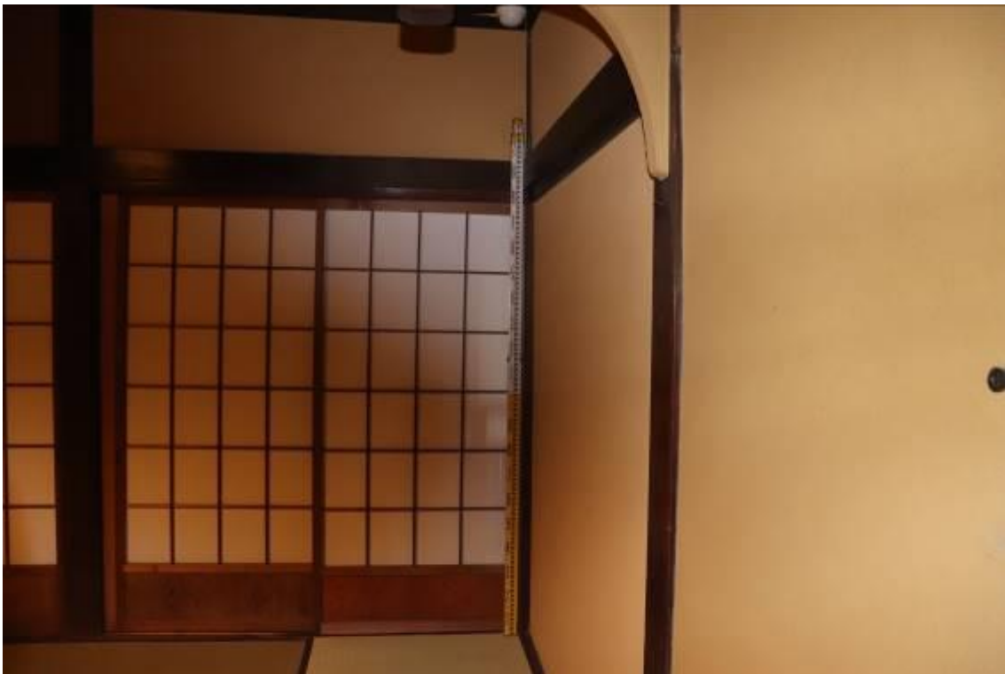
小姓の間応急修繕状況（令和元年度）
