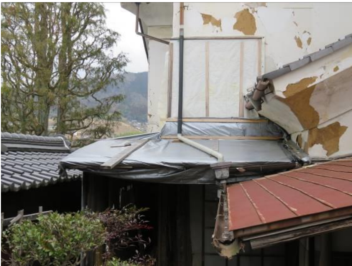
小姓の間外側壁面被覆措置小姓の間応急修繕状況（平成 29 年度）
