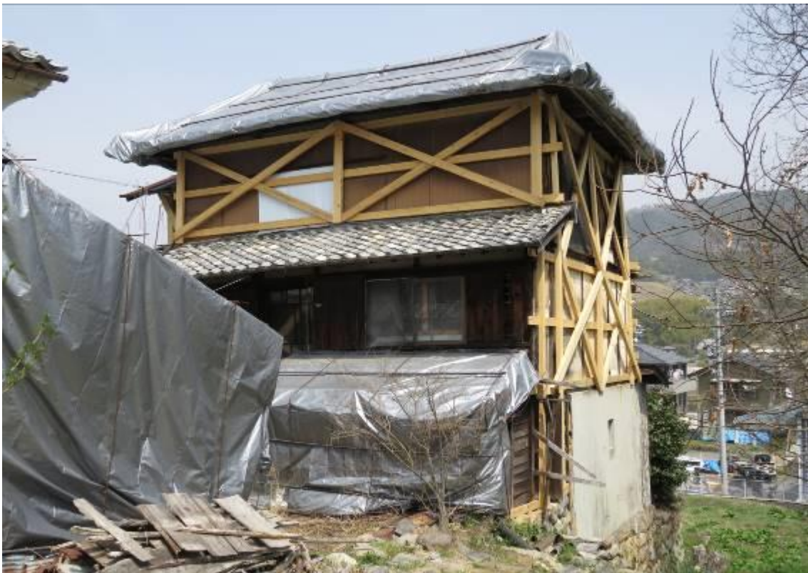
離れ補強工事（平成 29 年度）
