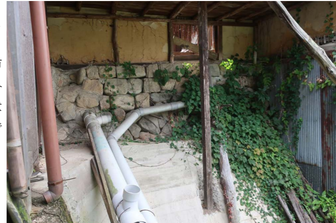
石垣を貫通する塩ビ管
