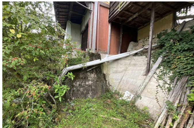
石垣面に下ろされた塩ビ縦管と横引管
