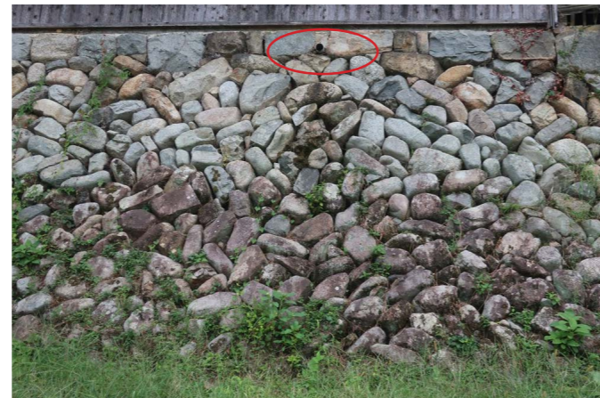
石垣上部に埋設された塩ビ管
