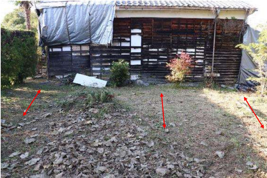
庭園部等①～③（南東から撮影） 区画遺構調査・整地層調査
