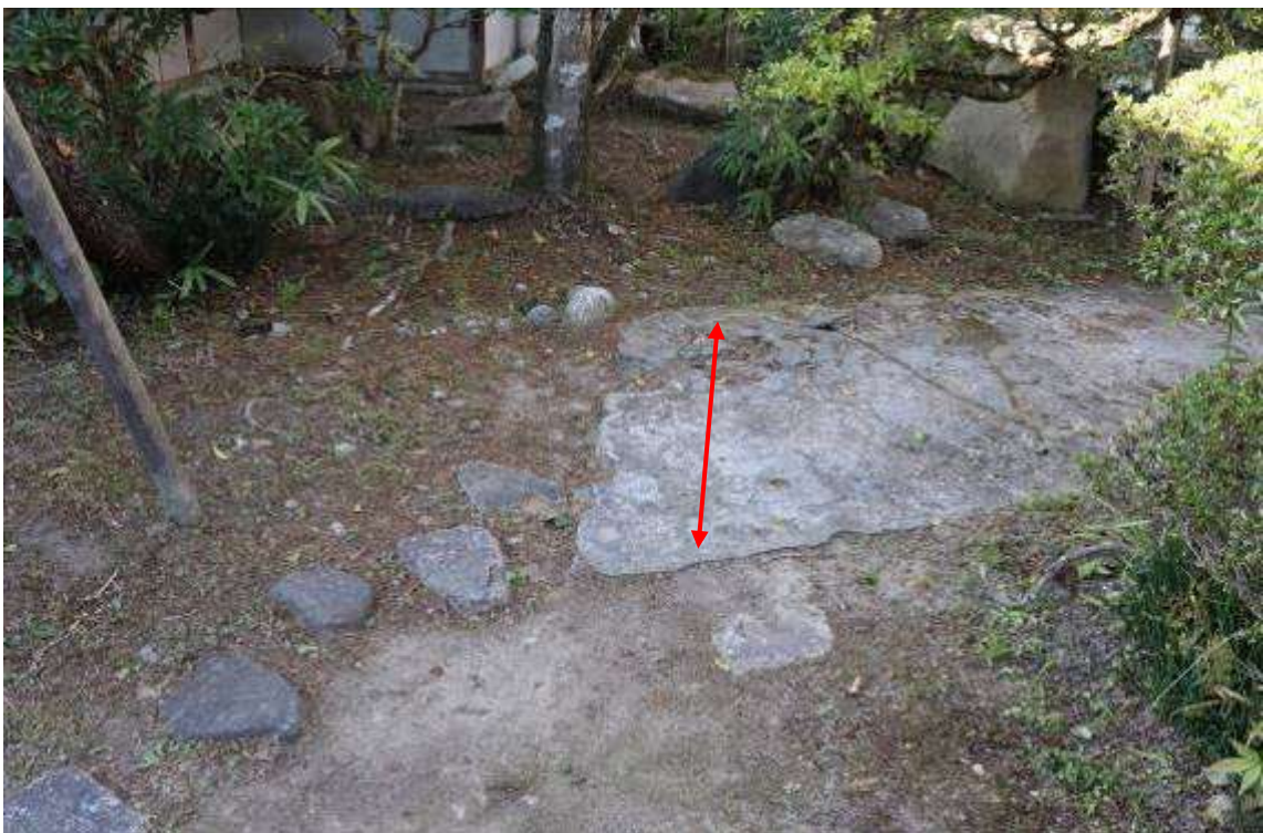
庭園部等⑭（南東から撮影） 玉石舗装（コンクリート舗装下）遺構調査
