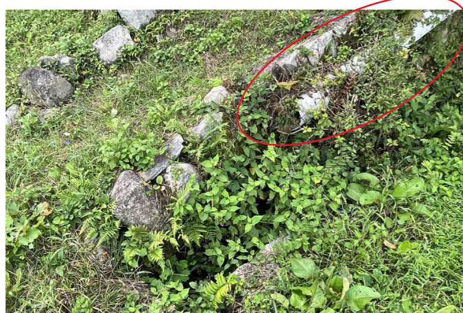
排水溝への接続
