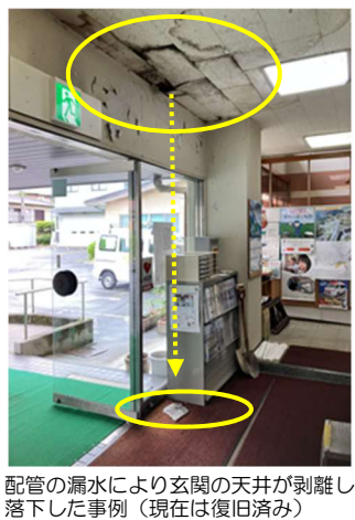
配管の漏水により玄関の天井が剥離し、落下した事例（現在は復旧済み）
