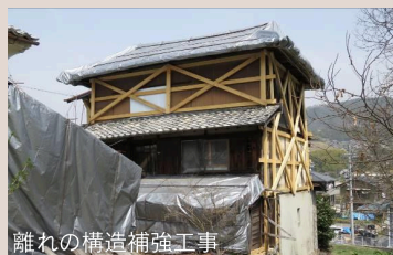
離れの構造補強工事
