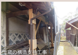
土蔵の構造支持工事
