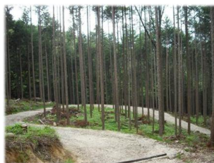
[作業道の開設と間伐実施林]
