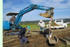
コンクリート水路の更新
