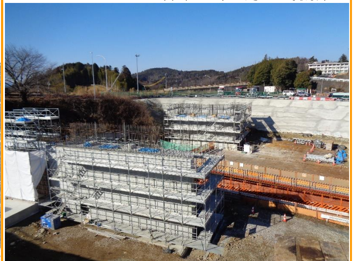
上り線側 県道上空に架かる橋の橋台
