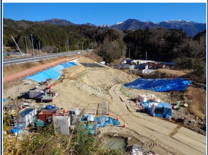
下り線側進入路
