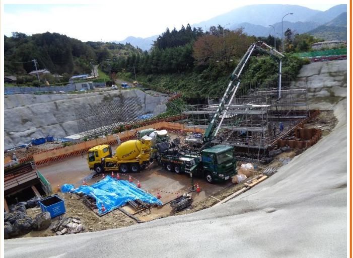
上り線側 橋台基礎工進む
