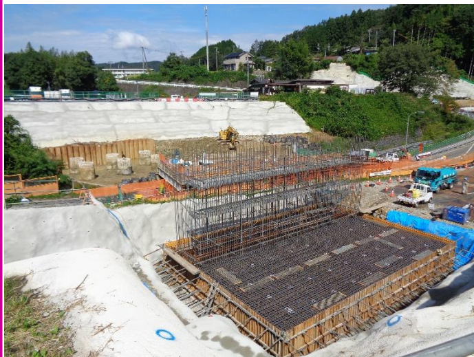
上り線側 県道上空に架かる橋の橋台基礎工
