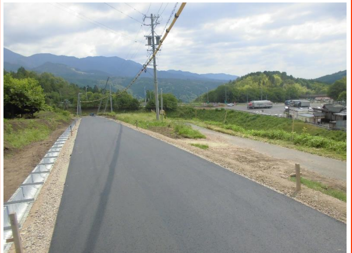
上り線 仮設道路完成
