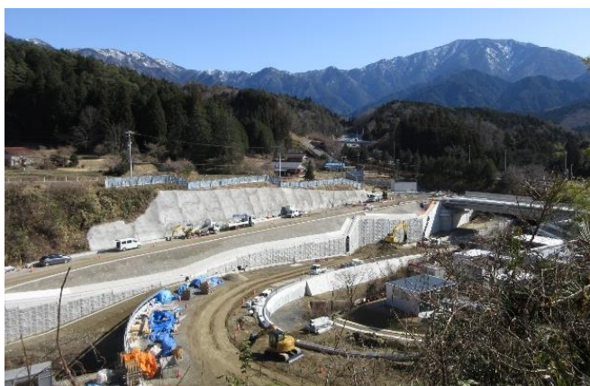
（上り線側工事：令和7年3月7日撮影）
