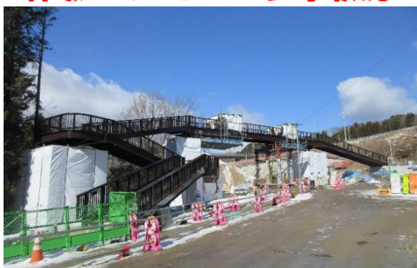
（下り線側工事：令和7年1月10日撮影）
