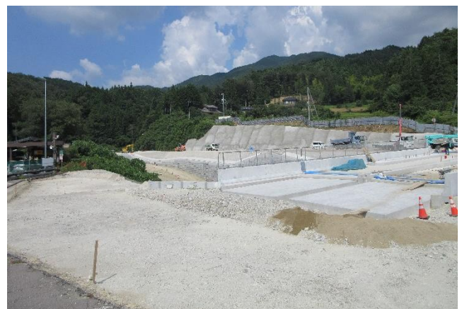
上り線側上部工工事（橋の工事）
