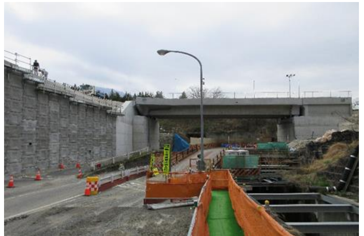
上り線側 上部工
