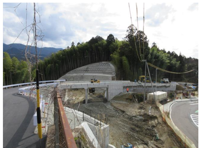
下り線側 市道神坂8号線小森橋付近
