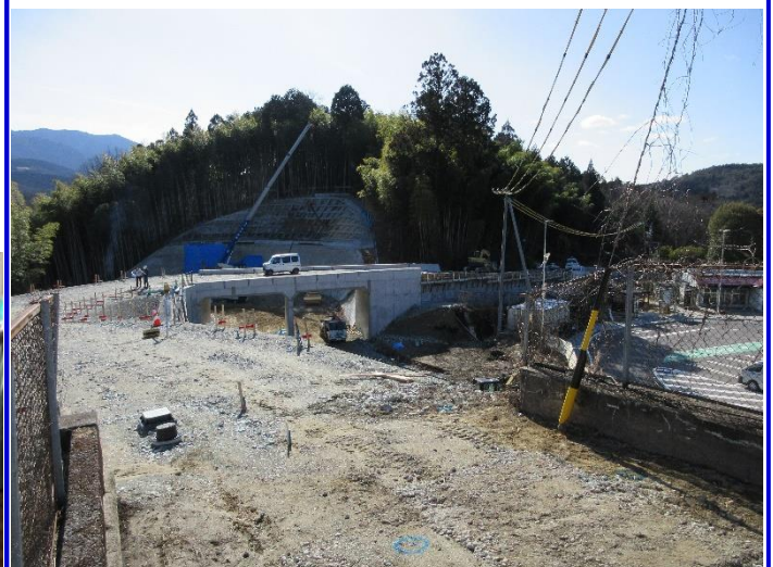
下り線側 8号線小森橋付近
