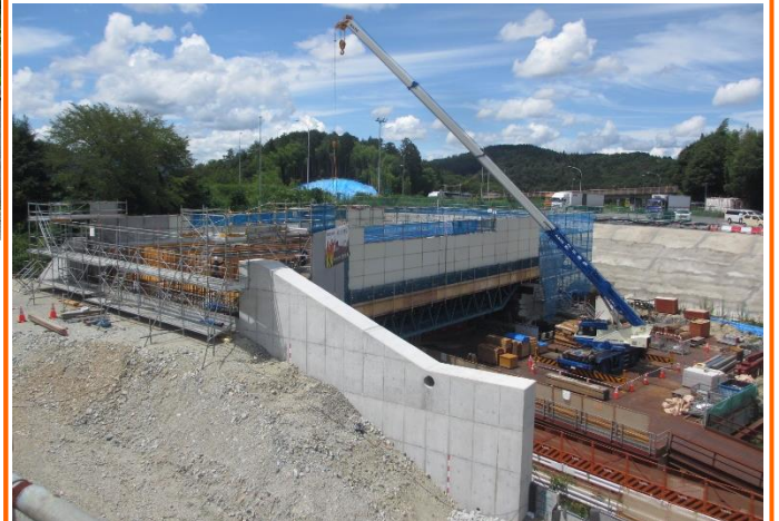
上り線側橋梁上部工工事実施中
