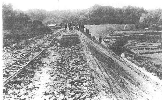
▲道床の土盛り工事(中津川市・昭和8年頃) 八屋敷地内にて。中央を走る線路は工事列車専用敷設された仮の線路と思われる。
