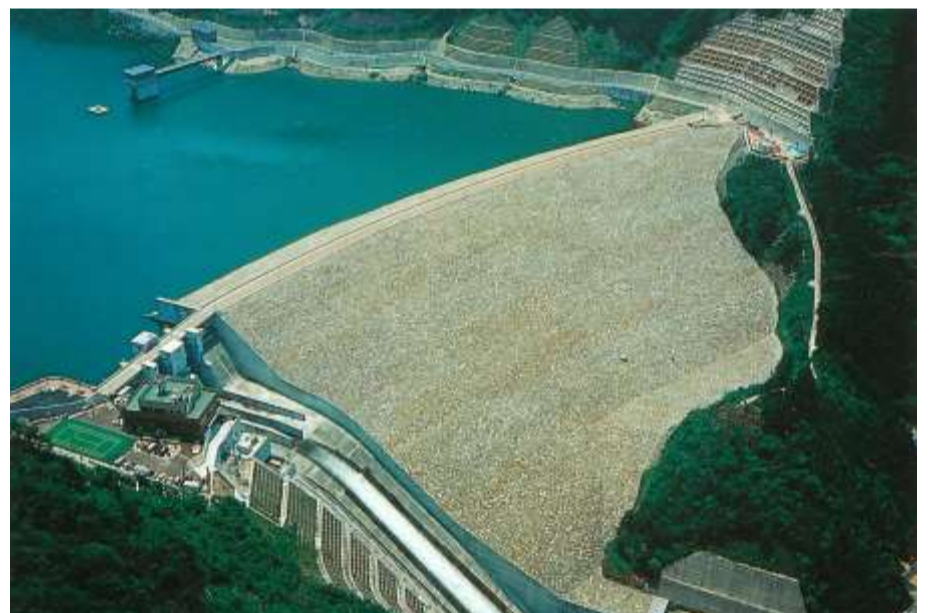
阿木ダム工事誌 巻頭写真 (水資源開発公団阿木川ダム建設所, 1991 年 3 月) より
