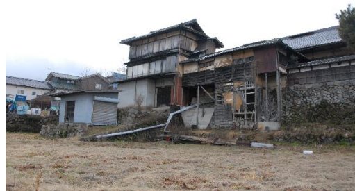
上写真：一時解体保管工事の対象となる 離れ・渡り廊下
